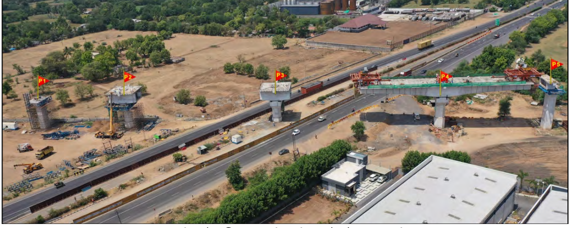
गुजरातमधील खेडा जिल्ह्यात पीएससी पुलाचे बांधकाम प्रगतीपथावर
